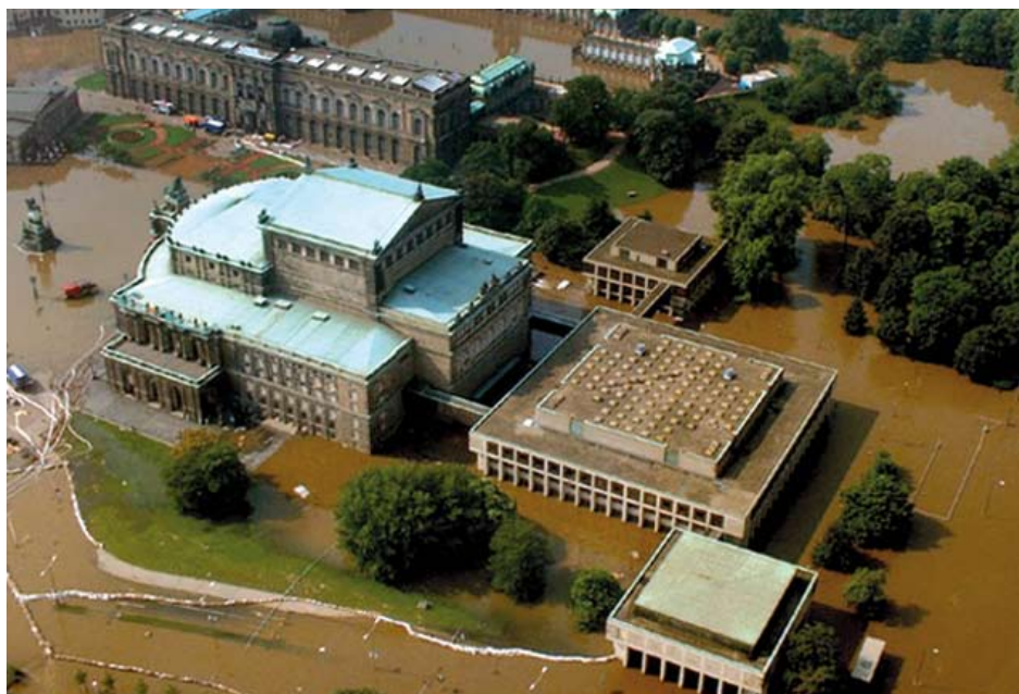
Bild 1: Hochwasser 2002 in Dresden, Semperoper (Quelle: Feuerwehr Dresden)
