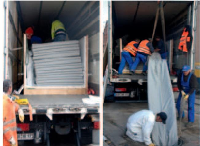
Schlauchliner mit Temperaturmesskabel (Einzug in den Abwasserkanal).
